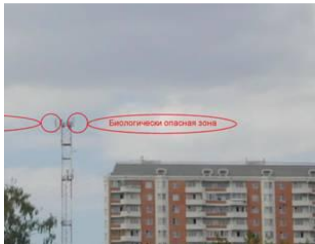
Рис 4. Антенна базовой станции сотовой связи (секторная, с углом раствора основного лепестка диаграммы направленности в горизонтальной плоскости - 60 градусов)
